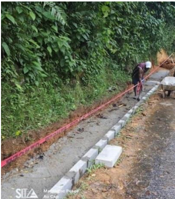
Au Cap Construction of the Montagne Posee roadside drainage
