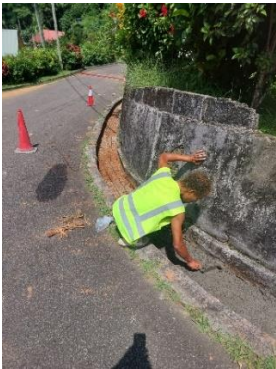
Au Cap Drainage maintenance
